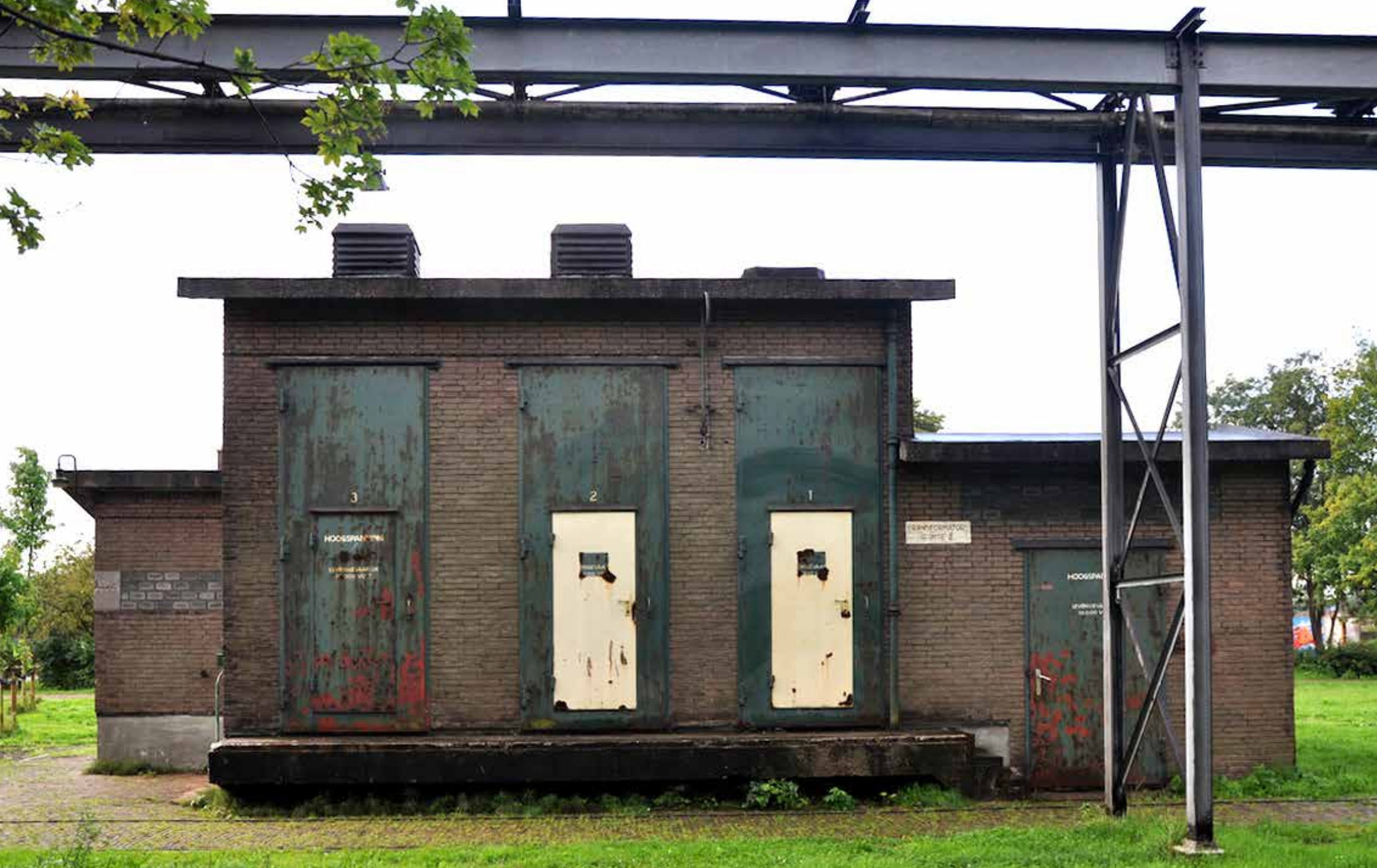
09/2015 Een pandje - Het Rijksvastgoedbedrijf stelt een transformatorhuisje uit de jaren 30 ter beschikking.
